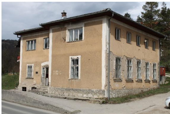
Slika 14: Stara zgrada odjela suda
