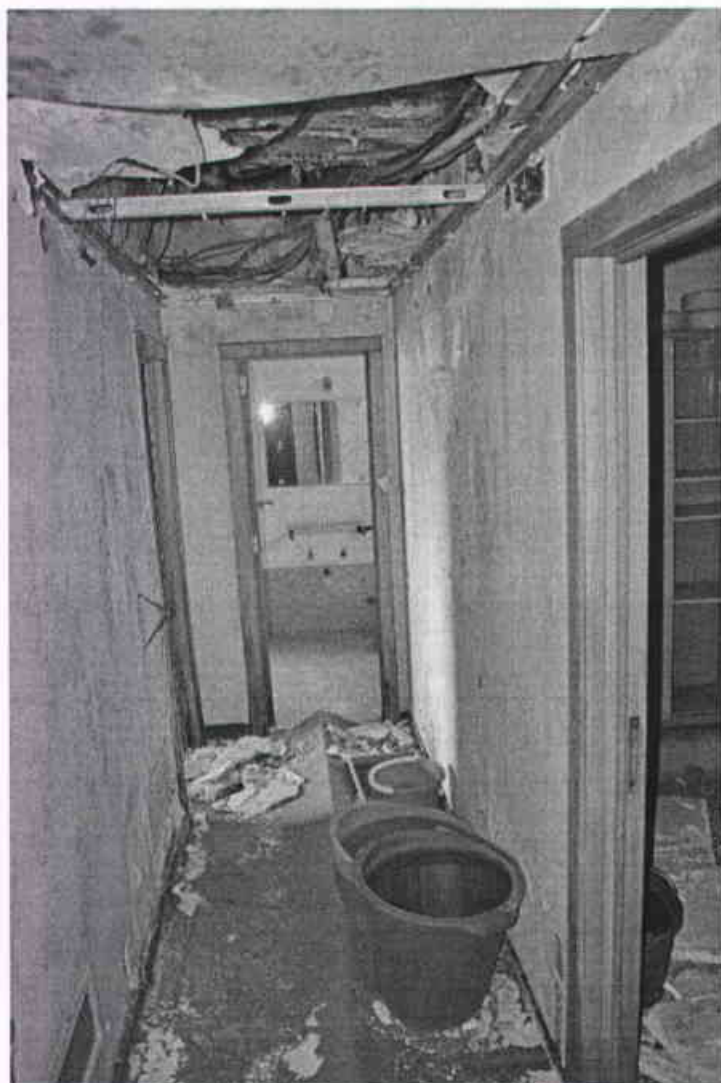
Продирање воде из крова који прокишњава (трећи спрат)
