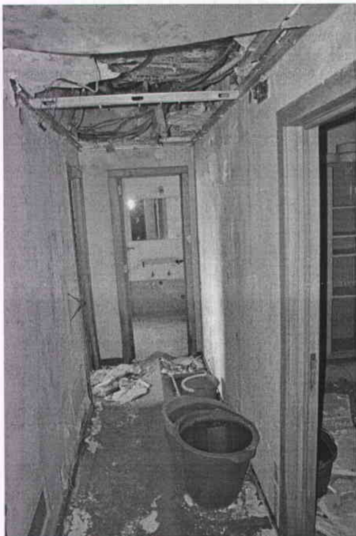
Prodiranje vode iz krova koji prokišnjava (treći kat)
