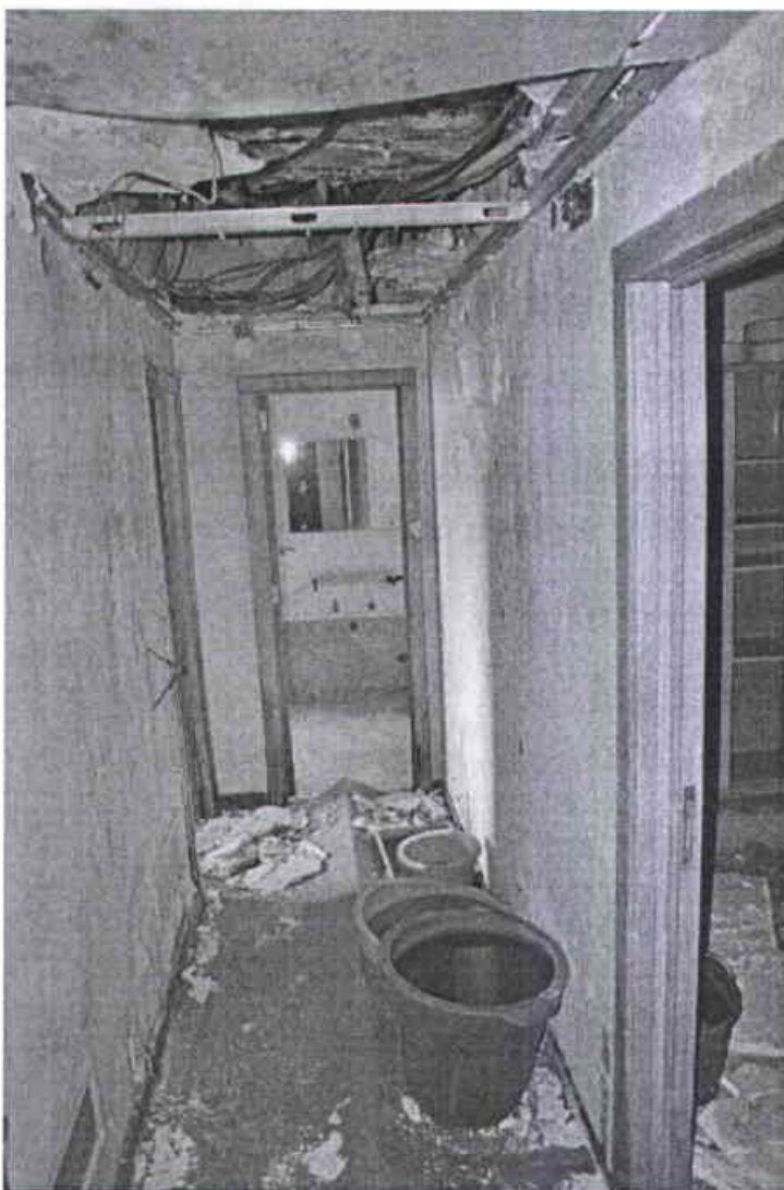
Prodiranje vode iz krova koji prokišnjava (treći sprat)
