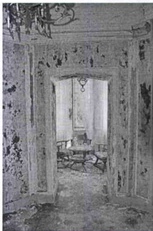
Oštećenja uzrokovana vodom (pod na terasi i buđ po unutrašnjim zidovima)
