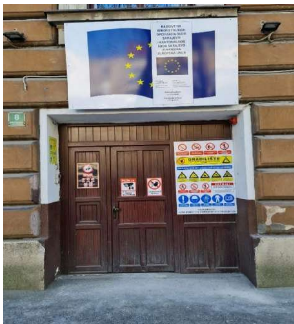
Слика 28: Реконструкција дијела зграде Палате правде у Сарајеву
