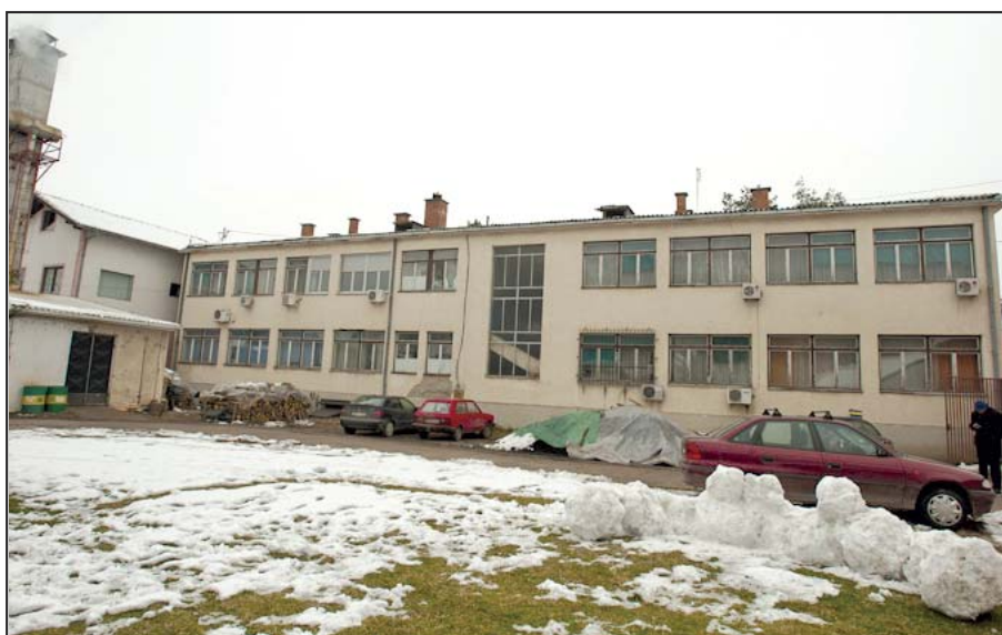
Слика 1.1.3: Зграда Основног суда у Модричи прије реконструкције
