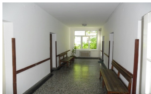
Slika 10: Izvršeni molerski radovi u hodniku suda
