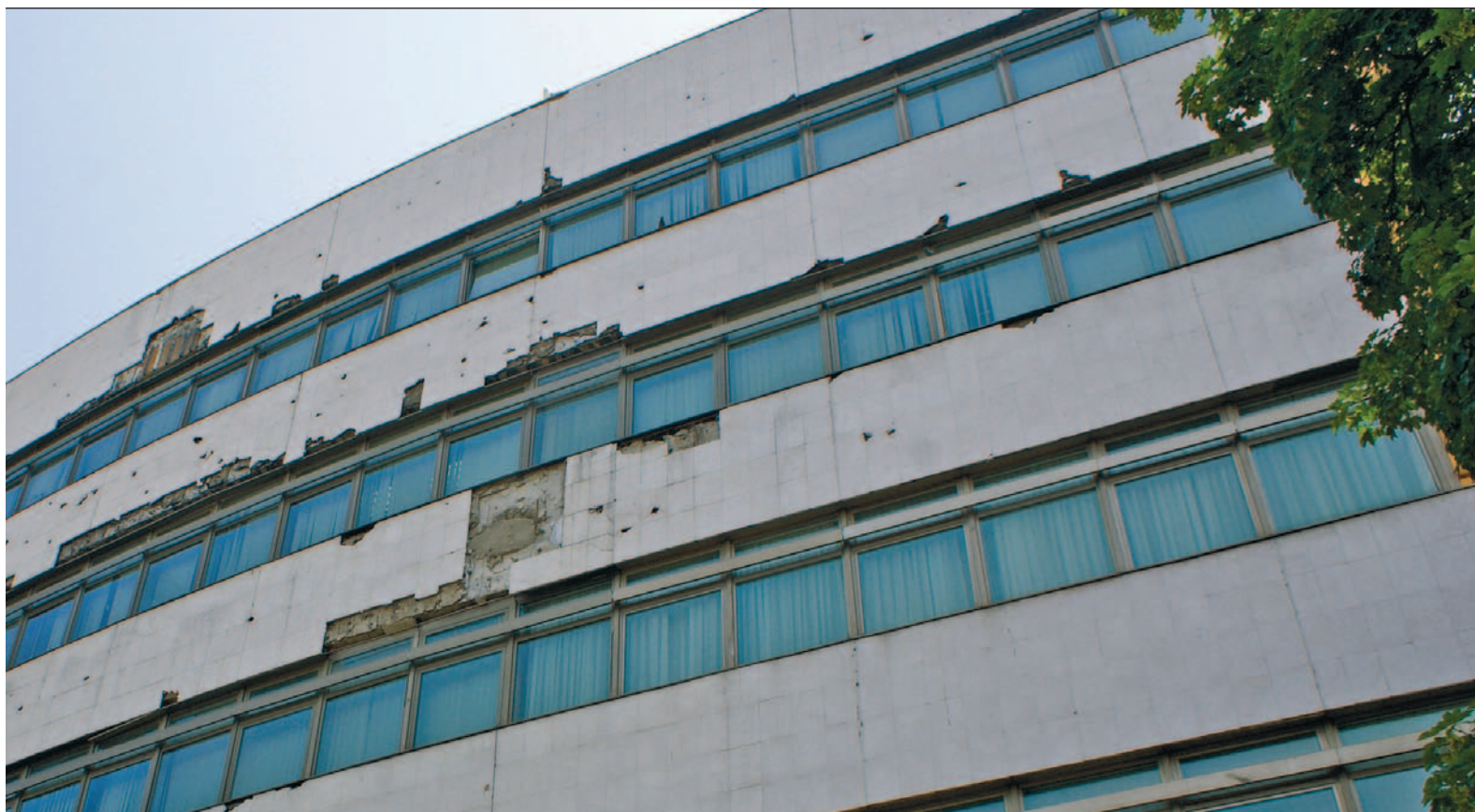
Zasjedanja domova su od drugog saziva održavana u djelimično obnovljenoj zgradi Parlamentarne skupštine Bosne i Hercegovine
